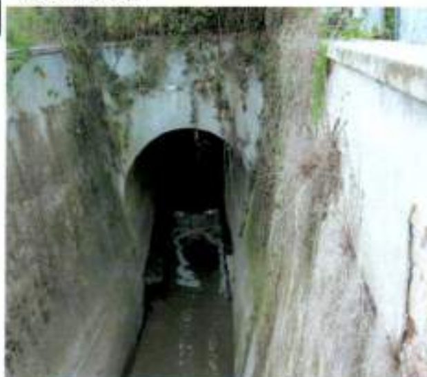
Lo scarico fognario nell'Almone dell'abitato di Quarto Miglio
